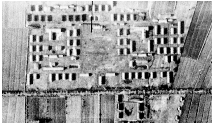
Blick auf das Marinelager Sterbur (um 1943). In der Bildmitte unten befindet sich heute der Kreisverkehr. BILD: ARCHIV GERD ROKAHR
