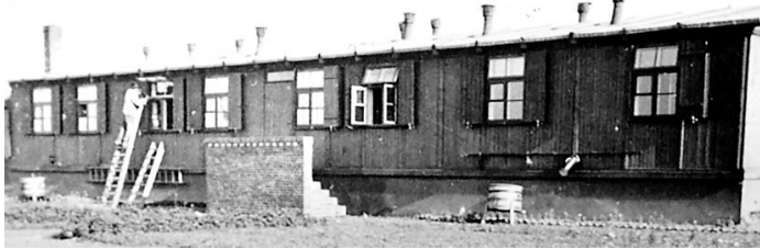
Die Baracken auf dem Gelände wurden mehrfach renoviert.
